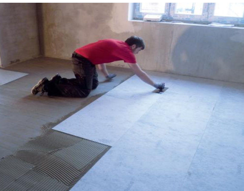
Verlijming van Geluidsisolatieplaat FDP 558 met Sopro`s No. 1.
