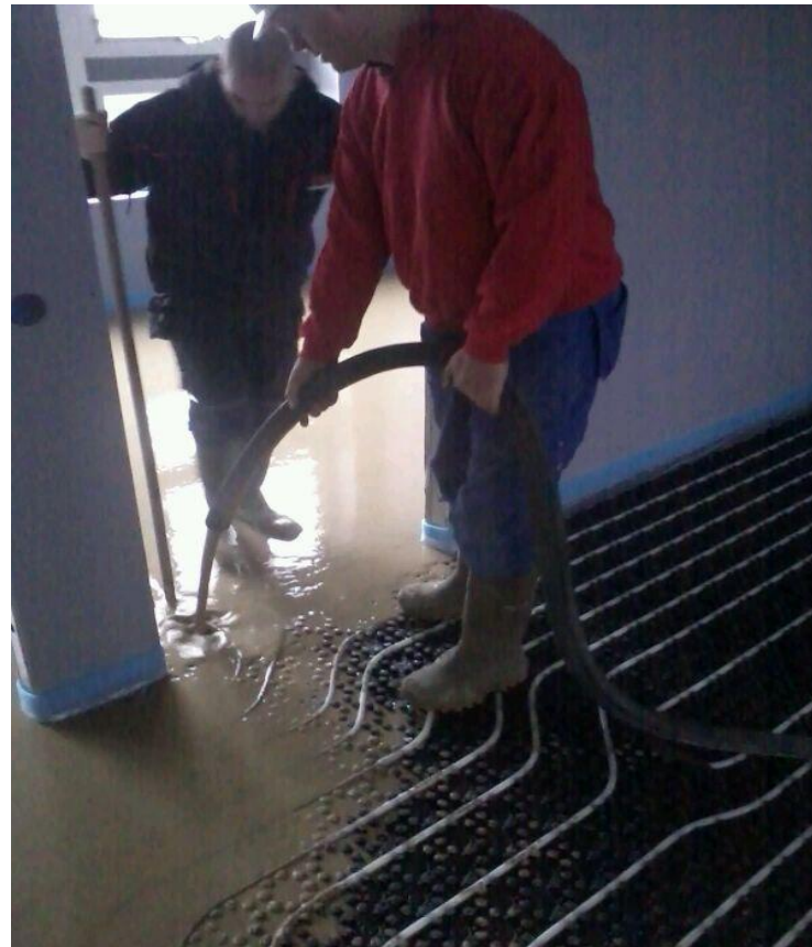
Aanbrengen van de Sopro Vezel Nivelleer FAS 551 met een pomp.
