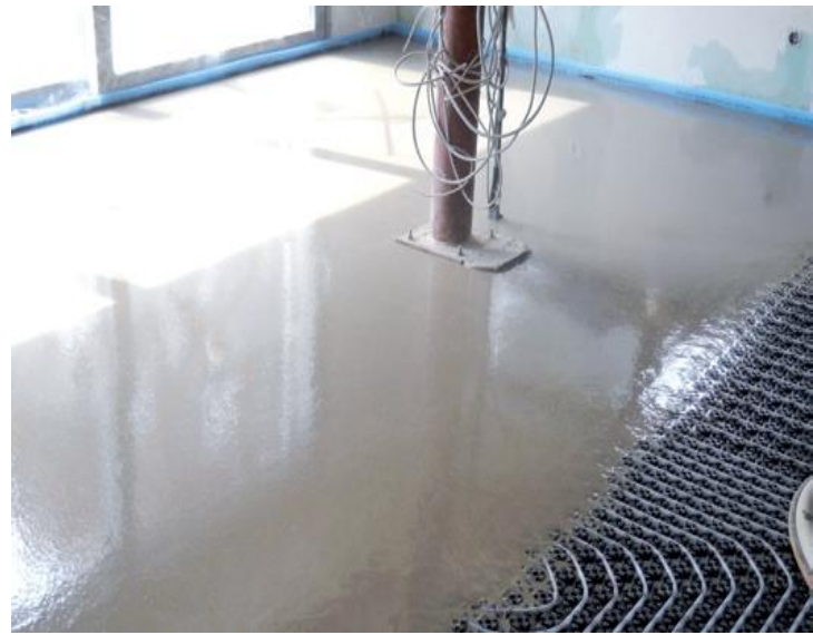
Aangebrachte Nivelleermassa.
