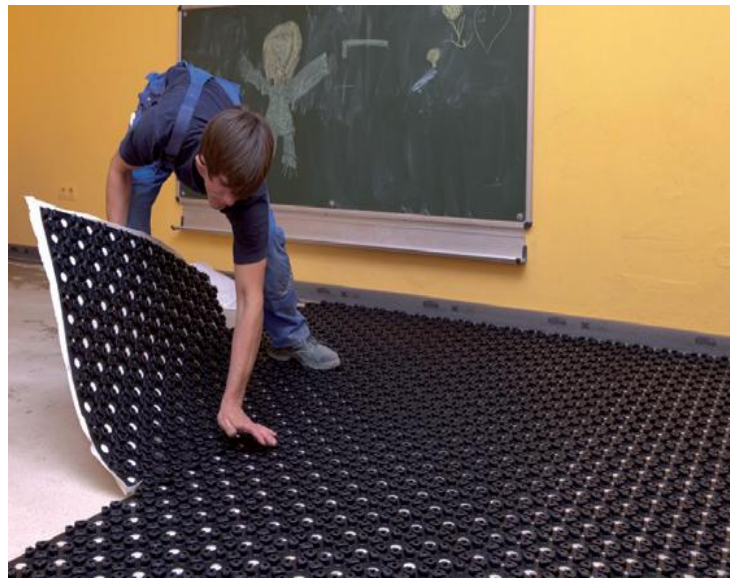
Verlegging van het draagsysteem van de verwarming. Bron: Kermi GmbH
